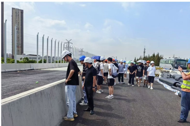
交通设计放样施工现场踏勘
